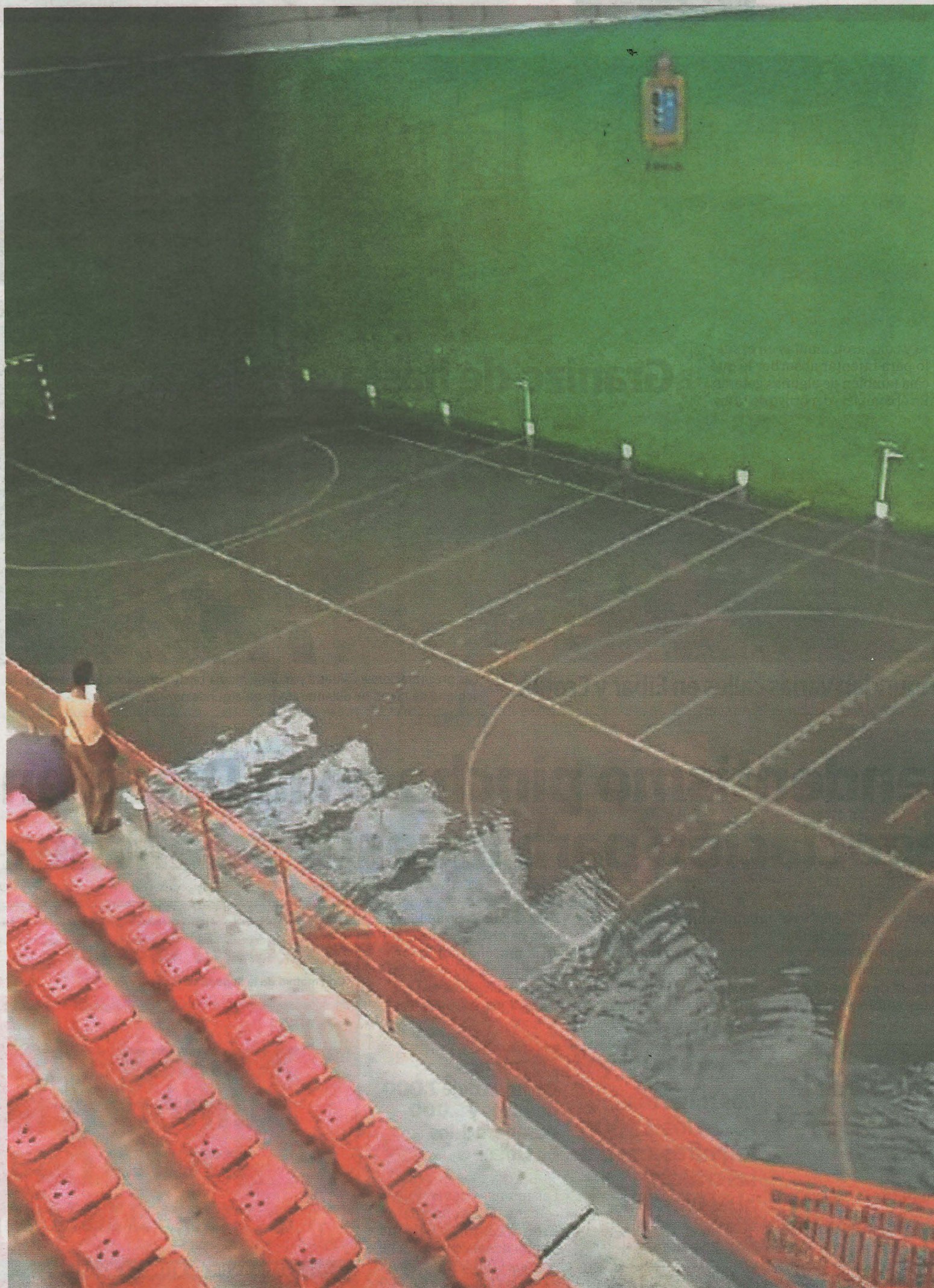
El agua entró hasta la cancha en el frontón Arizmendi de Ermua. E. C.
