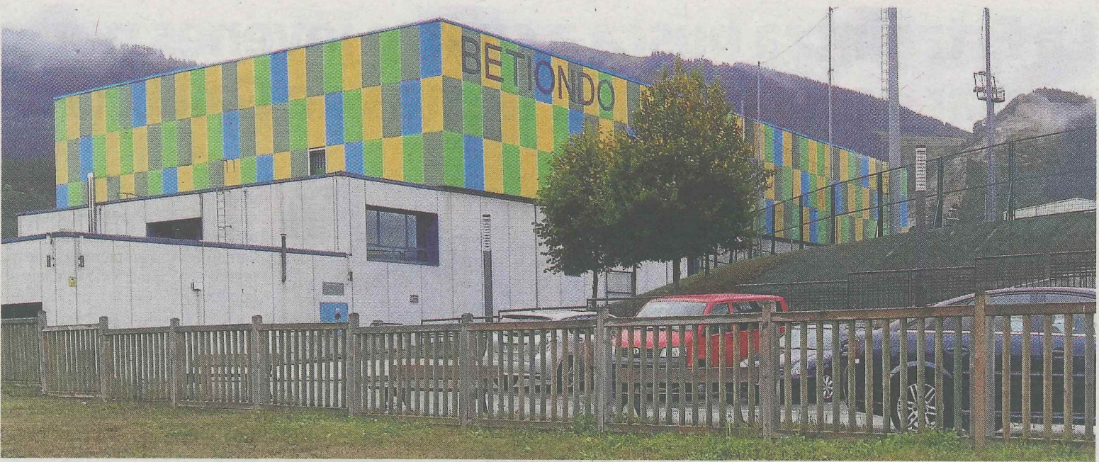
Aspecto que presenta el pabellón de Betiondo tras los trabajos de reparación ejecutados en los últimos meses. A. LASUEN
