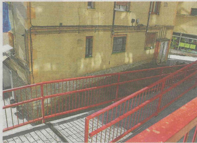
El derribo de la 'Casa Tote' ha permitido crear los dos accesos. A. L.
