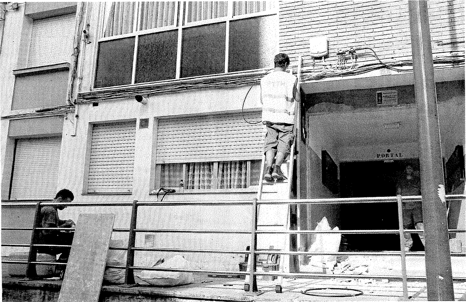
Un operario trabaja en la instalación de fibra óptica en un portal del barrio Ongarai de Ermua. :: AINHOA LASUEN
