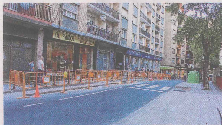
Estas obras de Iberdrola durarán, como mínimo, dos semanas. A. L.
