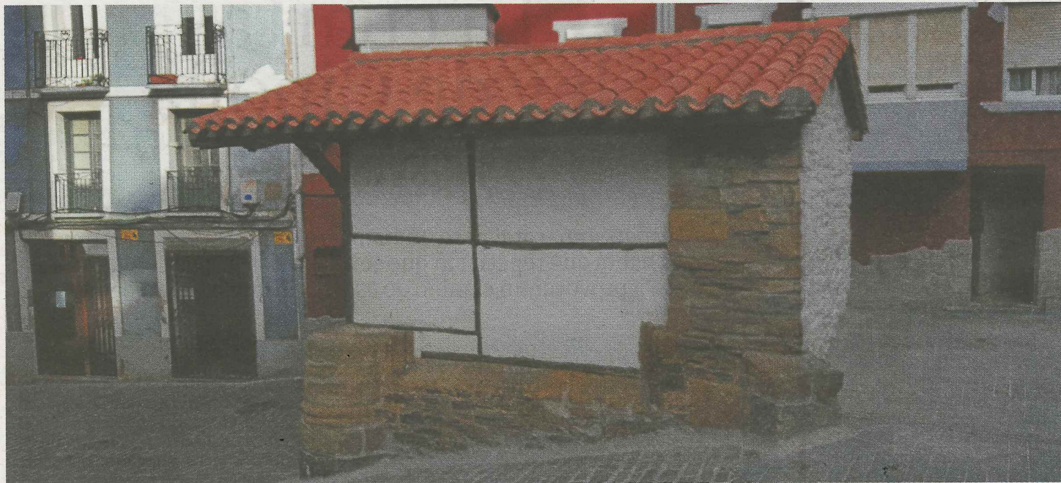
La ermita de Santa Cruz de Deba está siendo totalmente rehabilitada. :: FOTOS ANDER SALEGI
