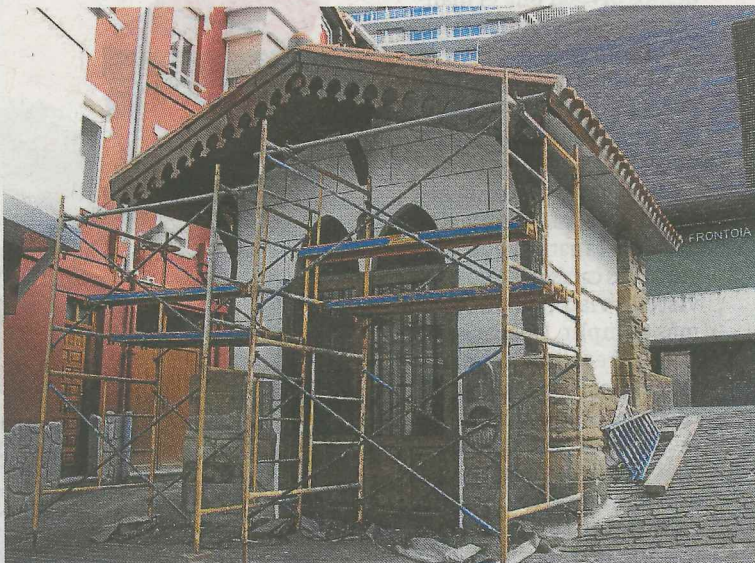
Los andamios han cubierto la fachada durante la obra.
