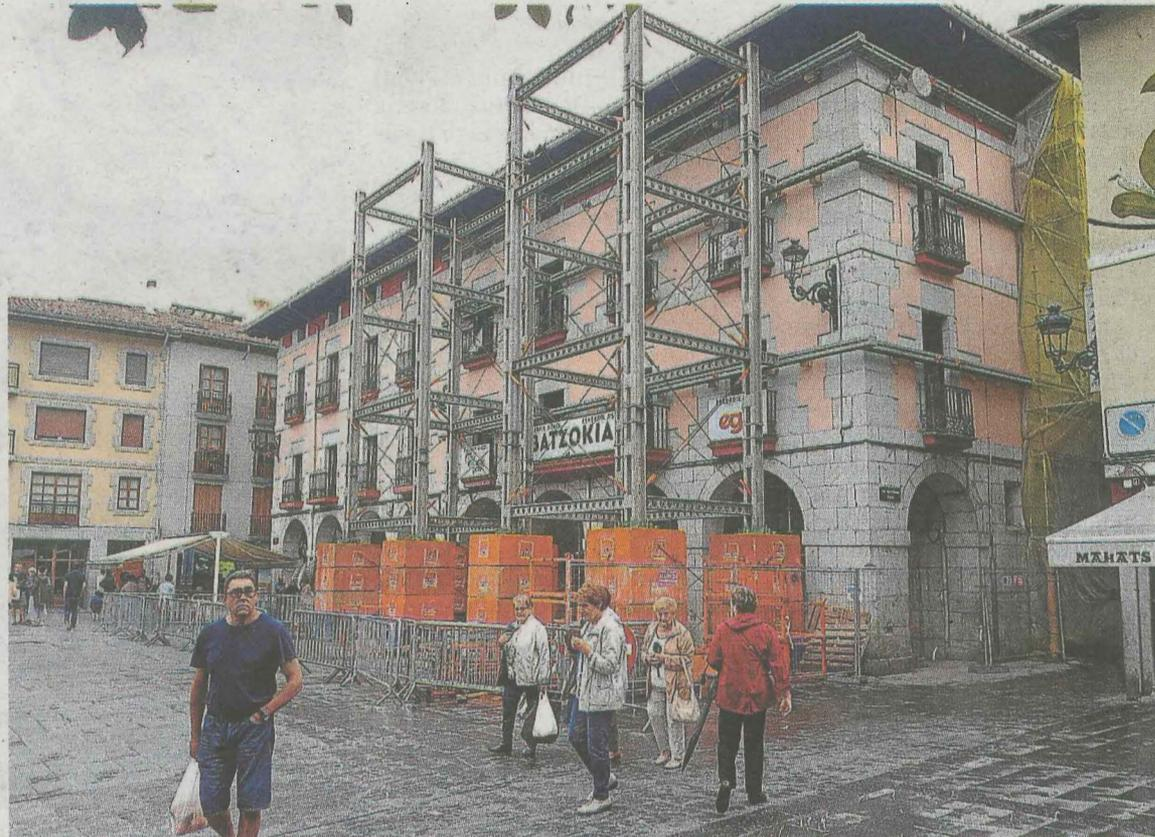
**Sujeción.** El inmueble aparece en la actualidad sustentado por una gran estructura metálica. ✪ AITOR
