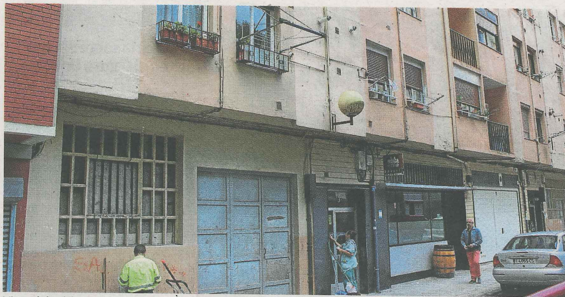
Vista del edificio de Okinzuri en el que se va a instalar el elevador. :: AINHOA LASUEN
