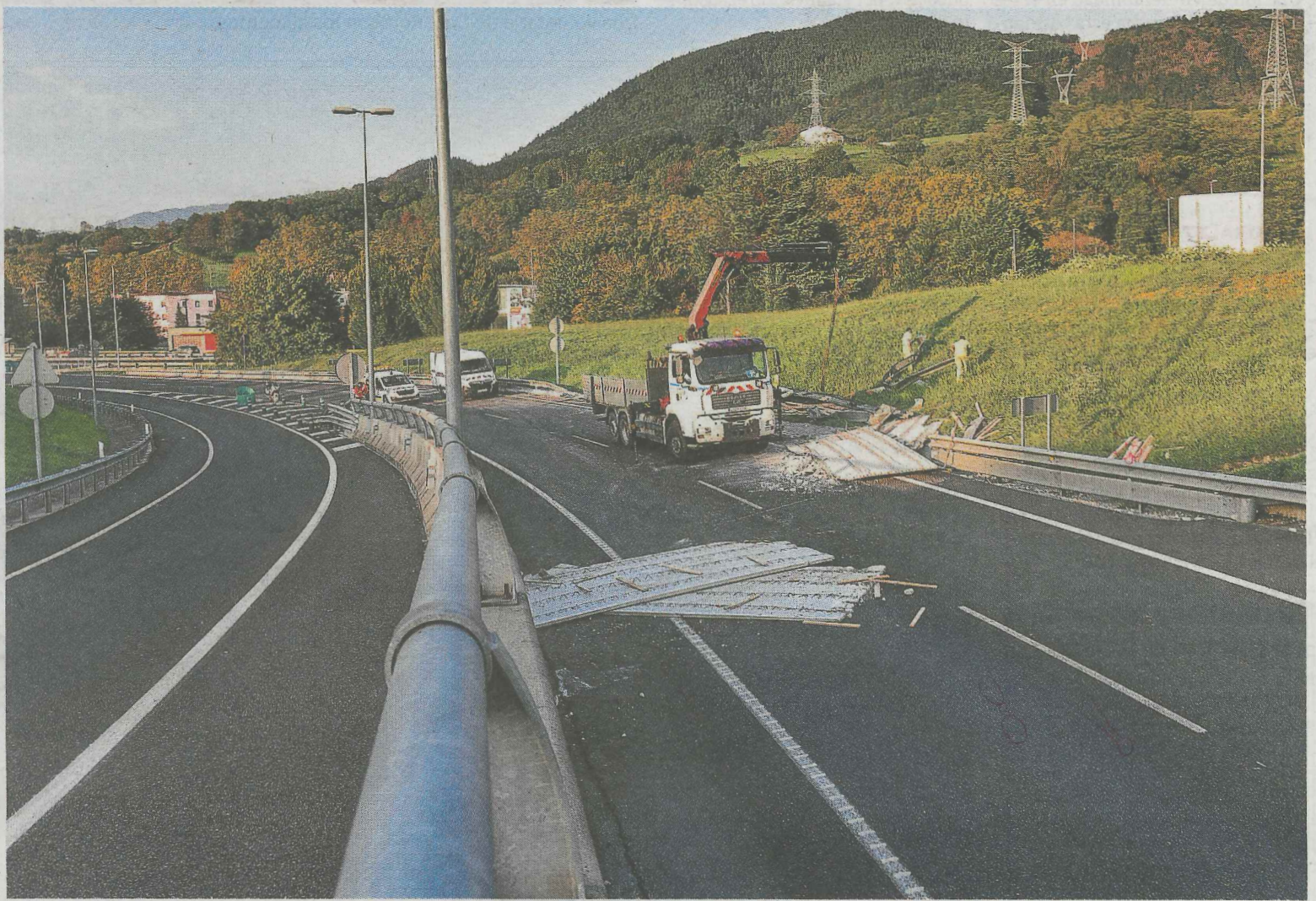
Una grúa retira las planchas que quedaron esparcidas por la carretera. ■ UNANUE
