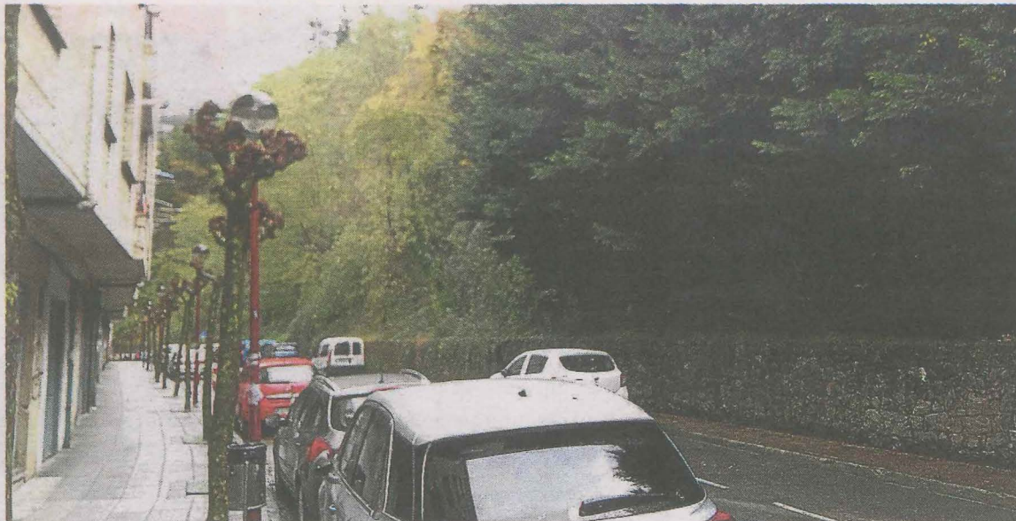
Talud de Goienkale afectado por los desprendimientos de tierra. :: A. LASUEN
