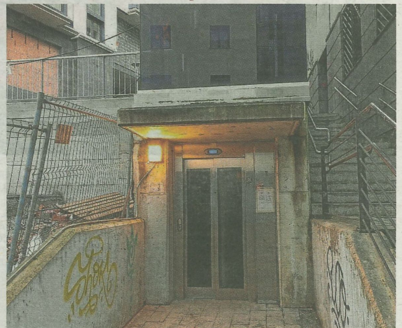
Las obras de Errekatsu obligan a cerrar un mes el ascensor. ECHALUCE
