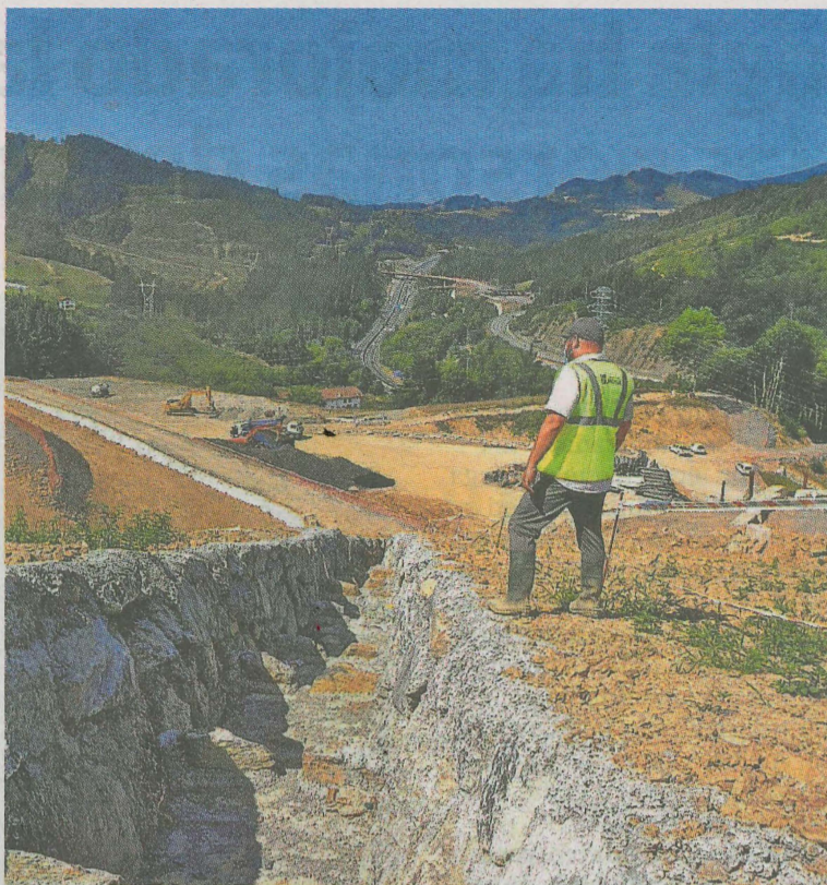
Imagen de los trabajos de estabilización del vertedero de Zaldibar. I. PÉREZ
