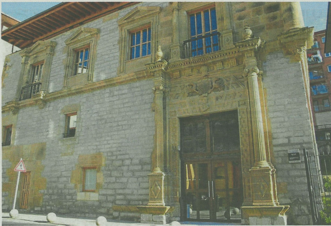
Este equipamiento municipal se utiliza como centro de reuniones y espacio para actividades diversas. A. L.
