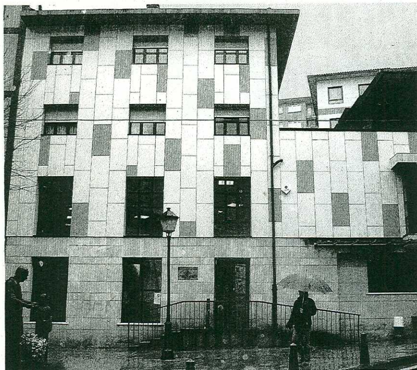
EDIFICIO. Imagen del exterior del actual Centro de Día de Ermua. / E.C.
