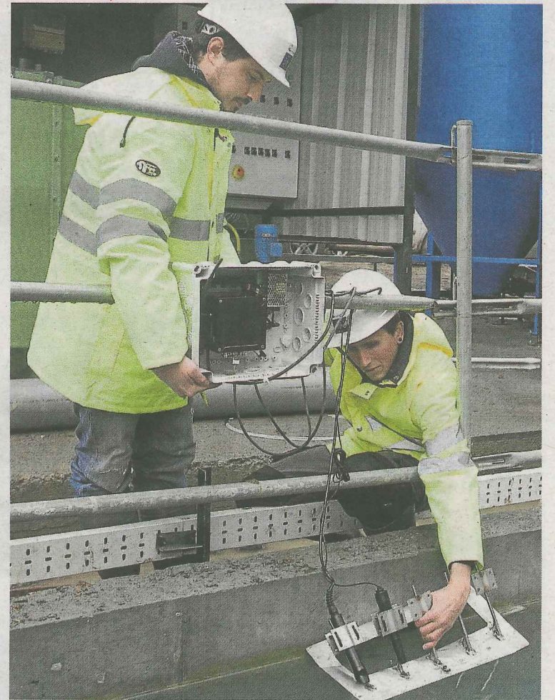
Colocación de sensores que miden varios parámetros en el agua.
