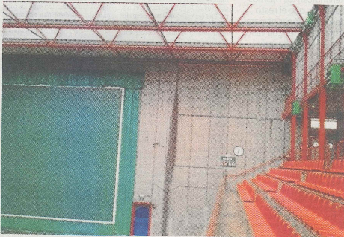
La nueva cubierta instalada ofrece mayor luminosidad a las instalaciones. A. LASUEN
