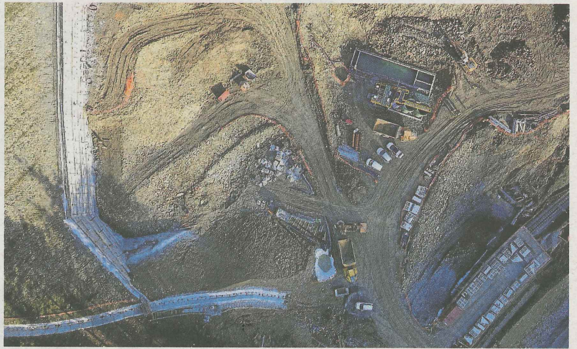
Imagen del dron de las obras del emboquille de un túnel en Ermua. Foto: Fulcrum
