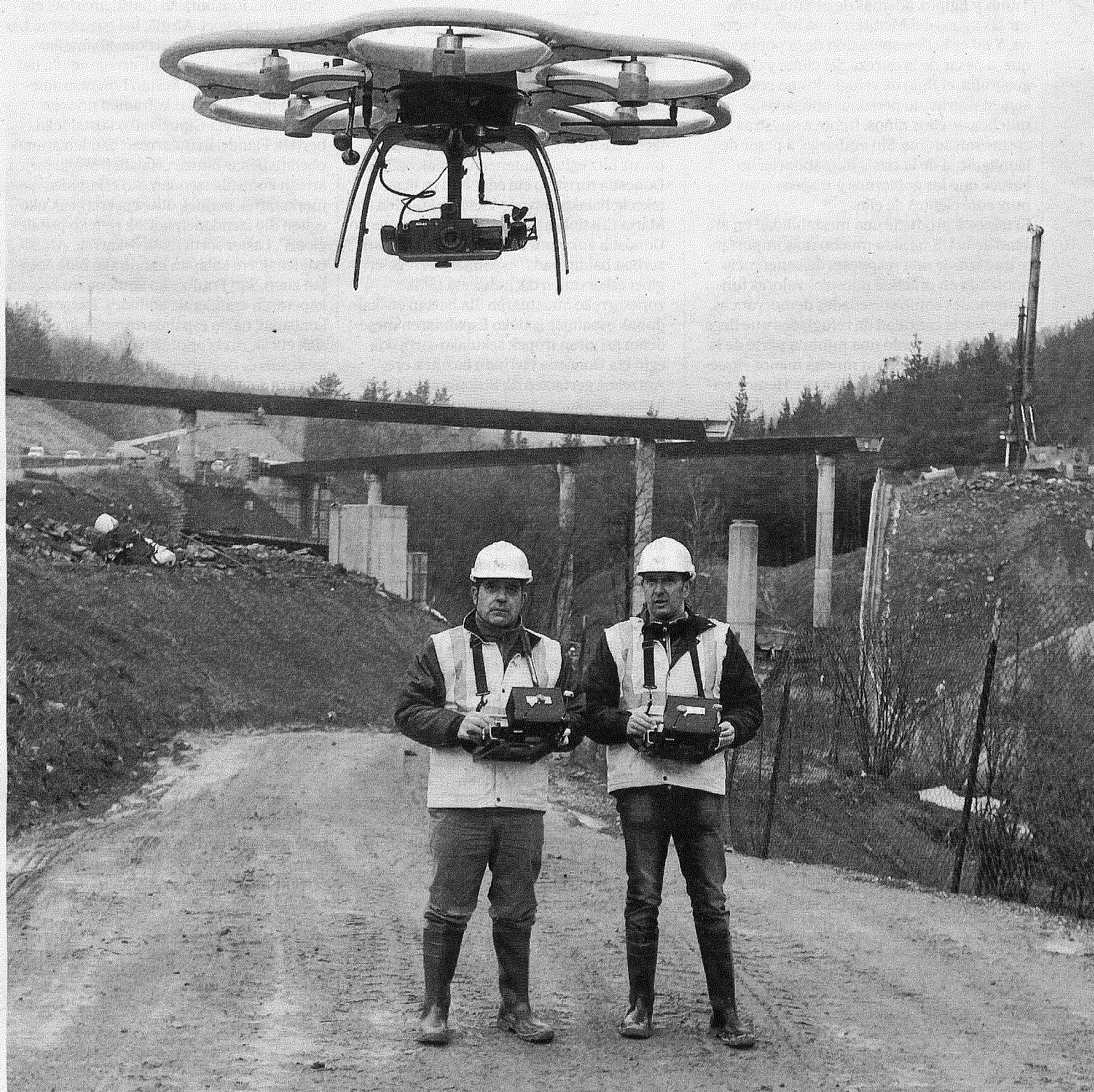
Los operadores del dron vigilan su ascenso antes de que el Aibot X6 vuele sobre los viaductos situados detrás. Fotos: Juan Lazkano
