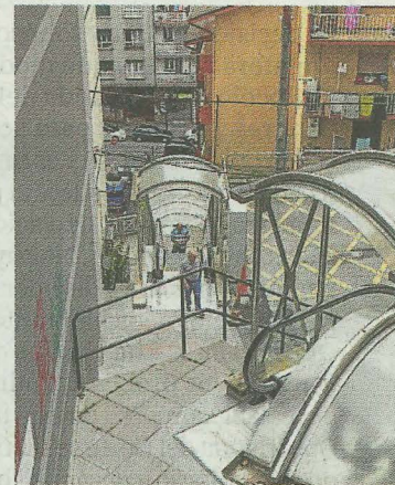
Tramos sustituidos. K.I.
