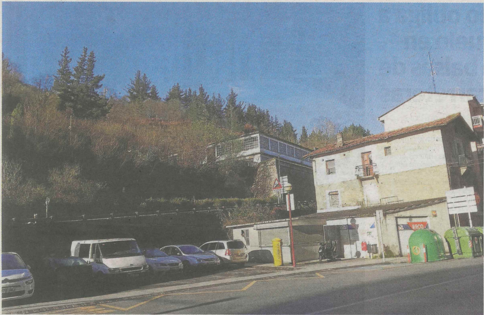
La zona Lomi-Power al fondo y en primer término, el espacio por el que transcurrirá el paso subterráneo bajo la subida a Areitio. :: A. LASUEN
