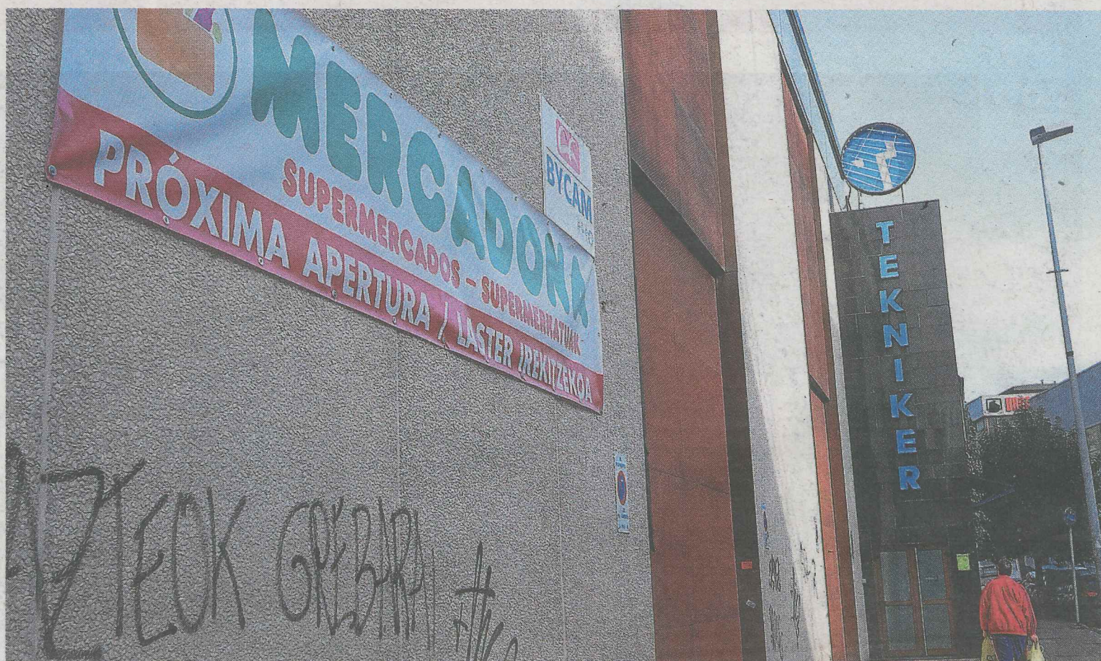
Mercadona se encuentra realizando los primeros trabajos para el derribo de la antigua sede de Tekniker, en Otaola. :: FÉLIX MORQUECHO
