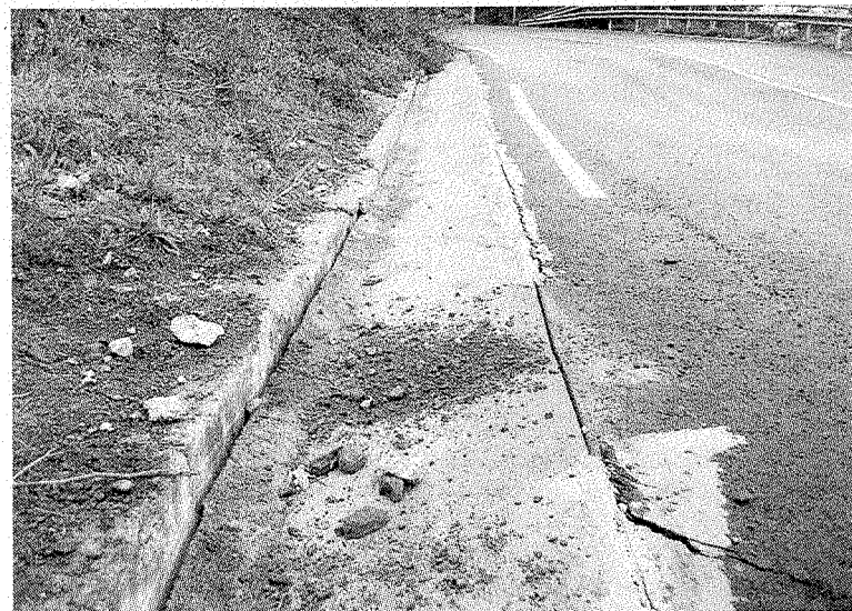
El vial de acceso a la playa cuenta con nuevas hendiduras.
