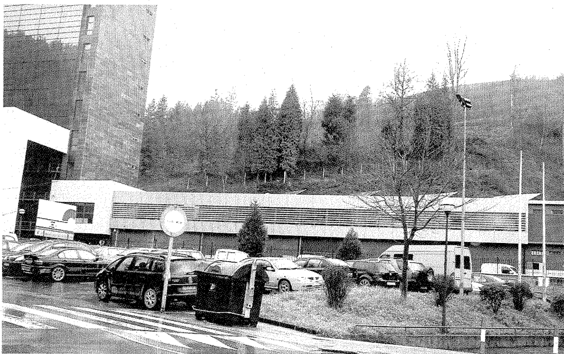
Los trabajos del centro de formación y promoción empresarial afrontan ya su recta final. :: A. L.
