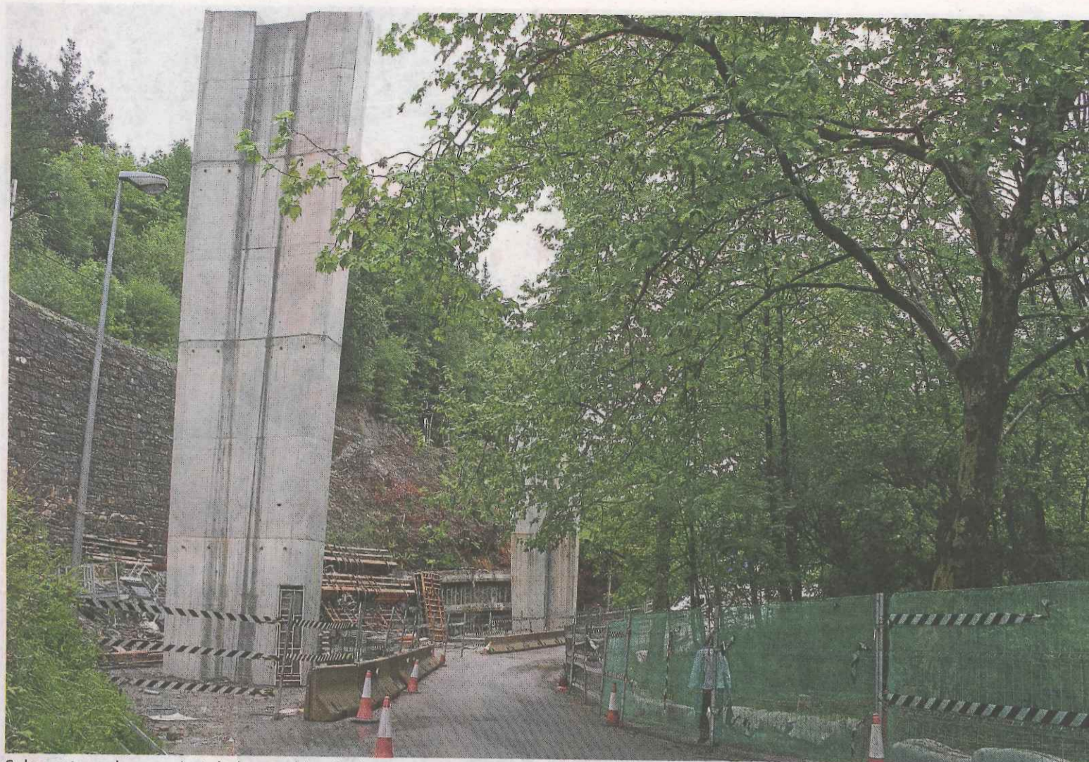
Sobre estas columnas, instaladas en el barrio de Eizaga, se asentarán los cajones para la variante de Ermua. :: A. LASUEN
