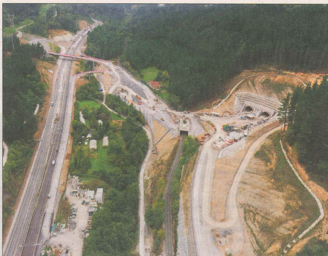
Esta gran infraestructura, de gran complejidad técnica, comenzó sus trabajos en 2014. ● DIPUTACIÓN FORAL DE BIZKAIA
