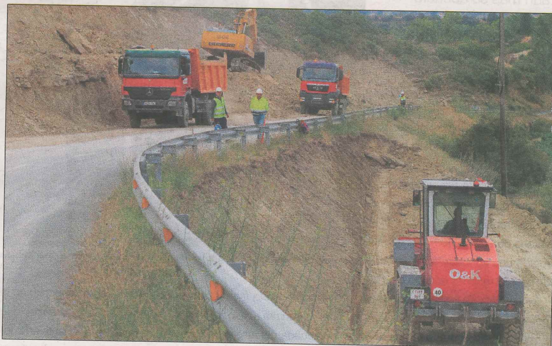
Los trabajos entre Assa y Elvillar están dirigidos a su ensanche y mejora. ● DIPUTACIÓN FORAL DE ÁLAVA
