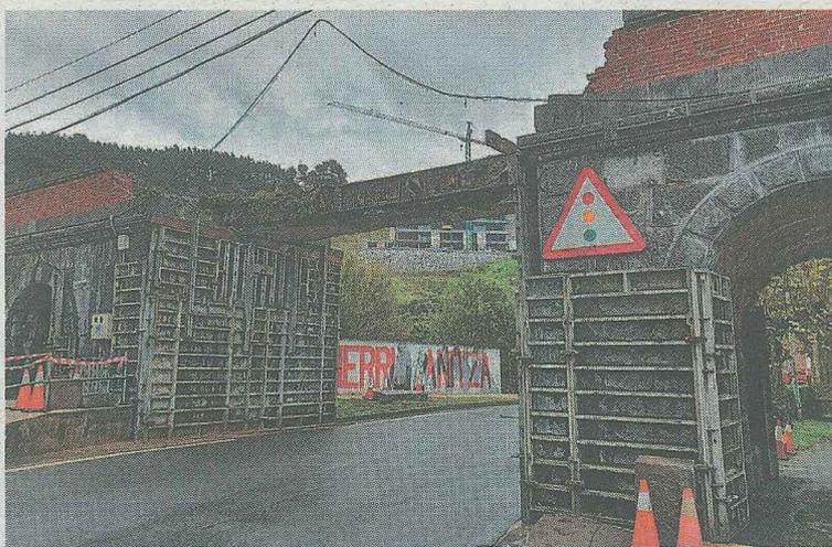
Dos momentos de las obras en el puente del ferrocarril, a la derecha, la vía metálica que se encontraron al demoler el hormigón. FOTOS ANDER SALEGI
