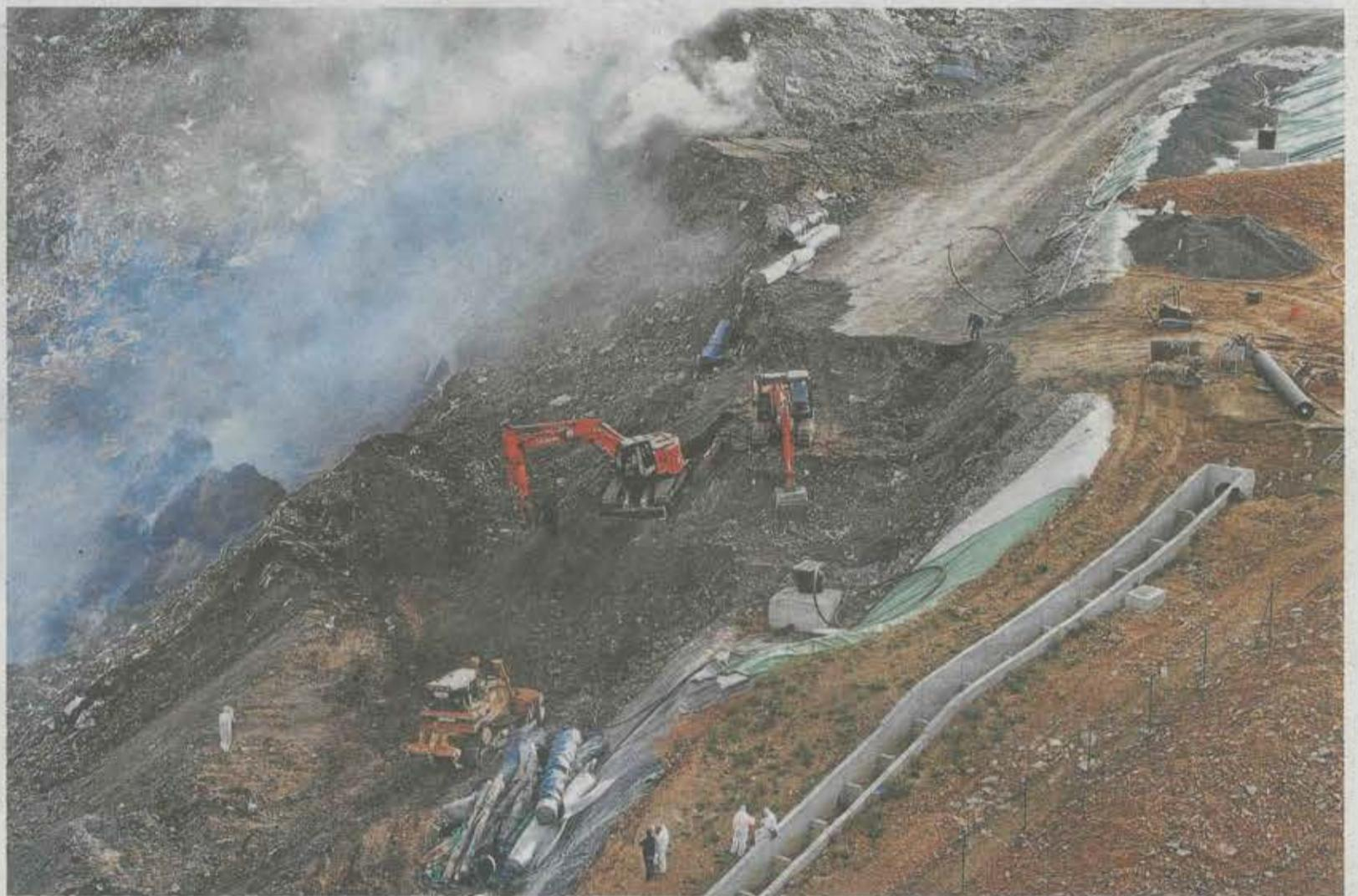
Imagen aérea de las labores para extinguir los incendios y estabilizar la ladera del vertedero de Zaldibar. IREKIA
