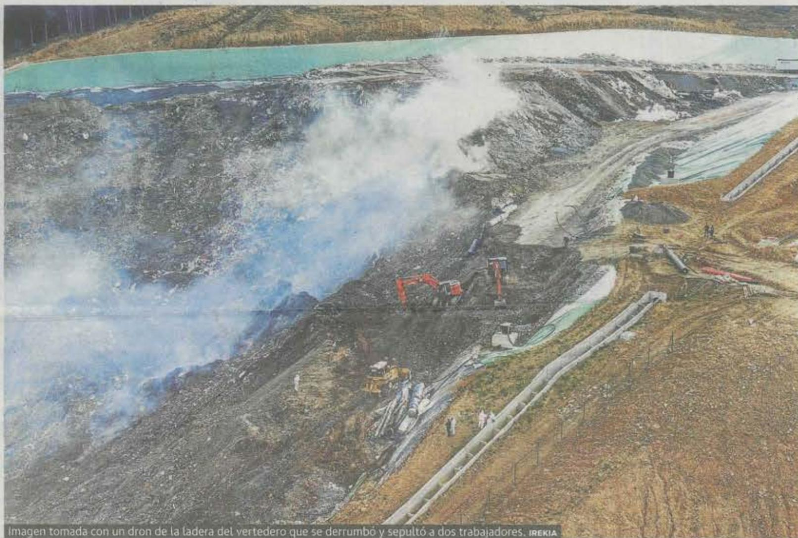
Imagen tomada con un dron de la ladera del vertedero que se derrumbó y sepultó a dos trabajadores. IREKIA
