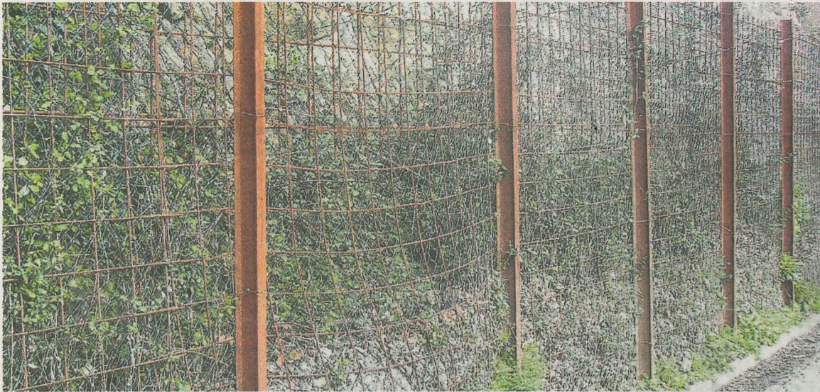
Ladera de Urasemendi que será reforzada para dotarle de una mayor seguridad a la acera. GORRITIBEREA
