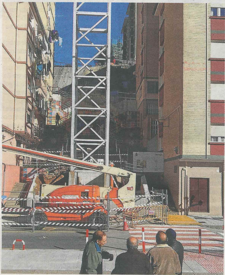
El ascensor se elevará casi 14 metros. :: A. LASUEN
