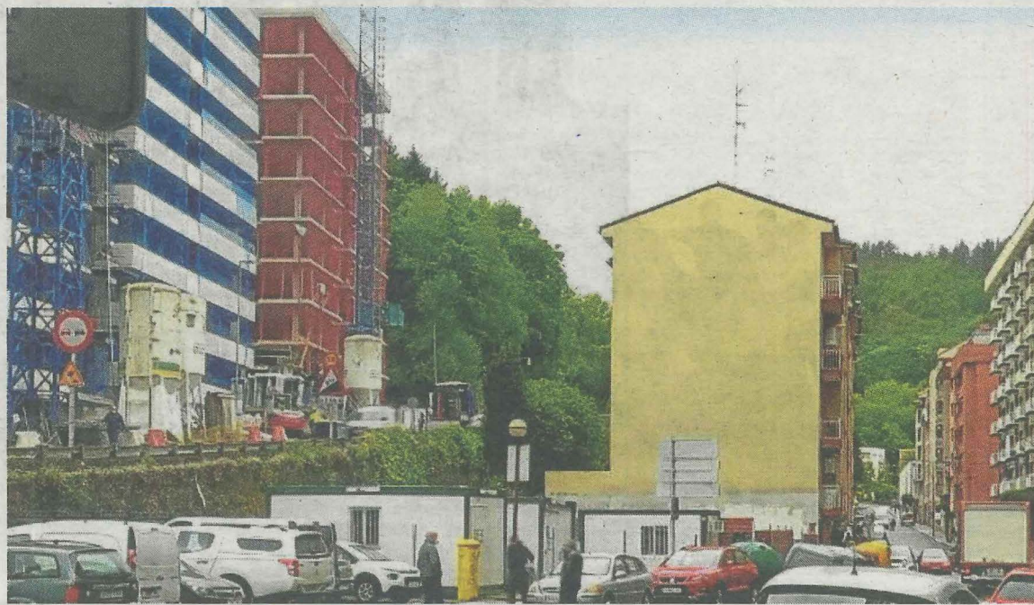
En la actualidad, se pueden ver varias casetas de obra en el lugar donde se generará el paso. A.LASUEN
