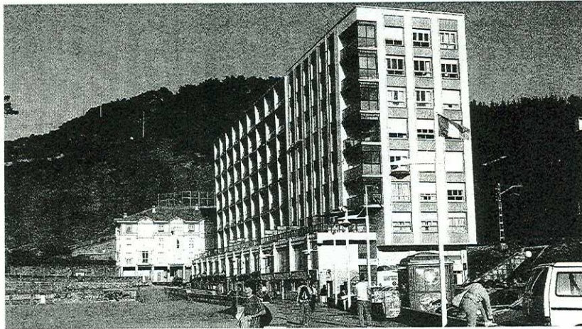
Los trabajos en la zona del hotel Miramar se alejan de la costa y se acercan a la carretera.
