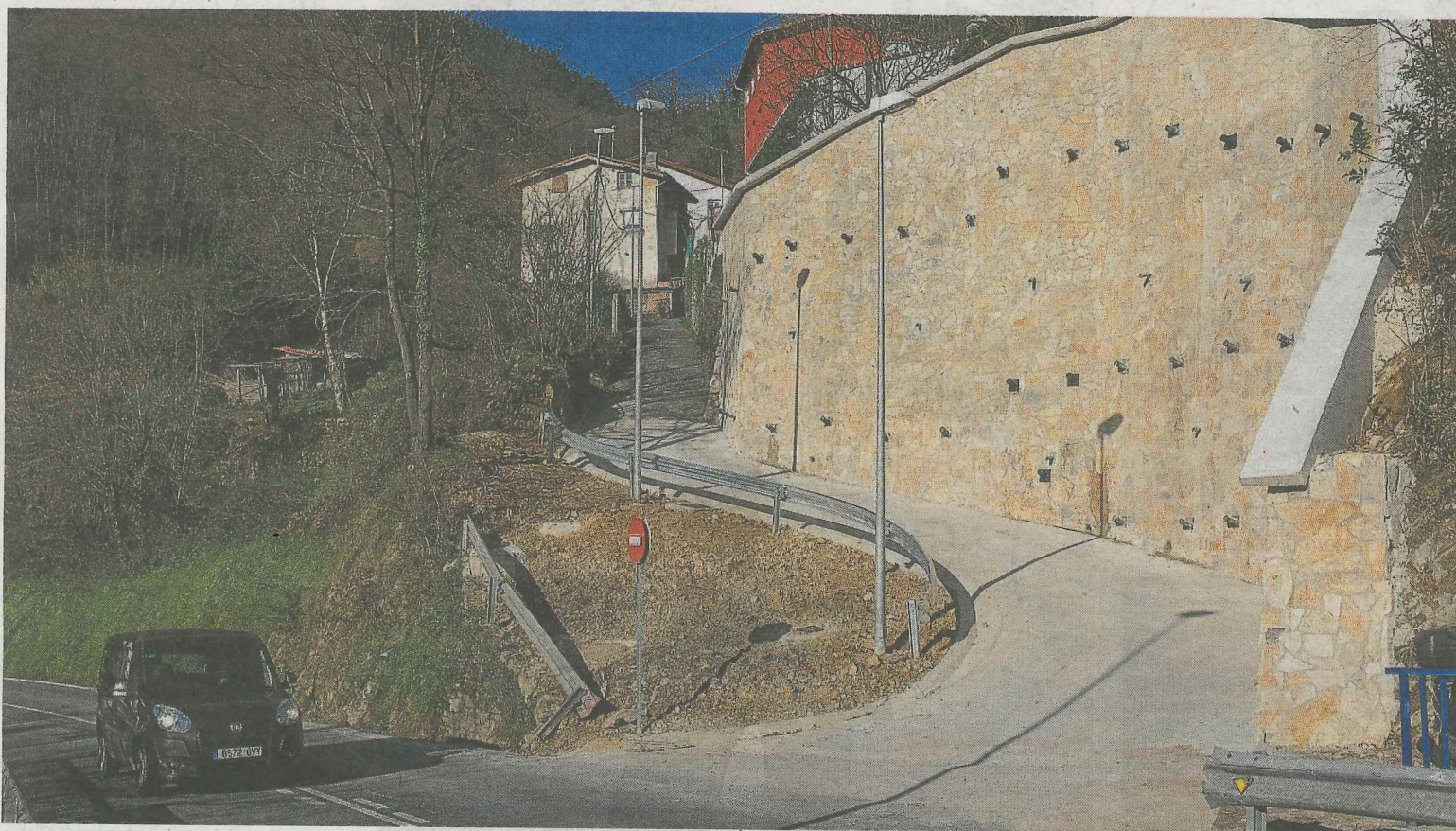
Construcción. La nueva acera se construirá entre el comienzo de la subida a Arrate y el cruce de la entrada de Miraflores. FÉLIX MORQUECHO
