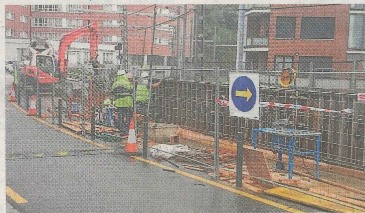
Las obras en la estación de Ermua ya en marcha. :: A. LASUEN
