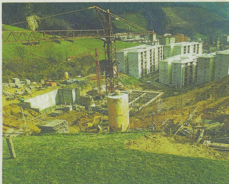
El centro educativo Santiago Apóstol, en construcción. ONGARAI ESKOLA
