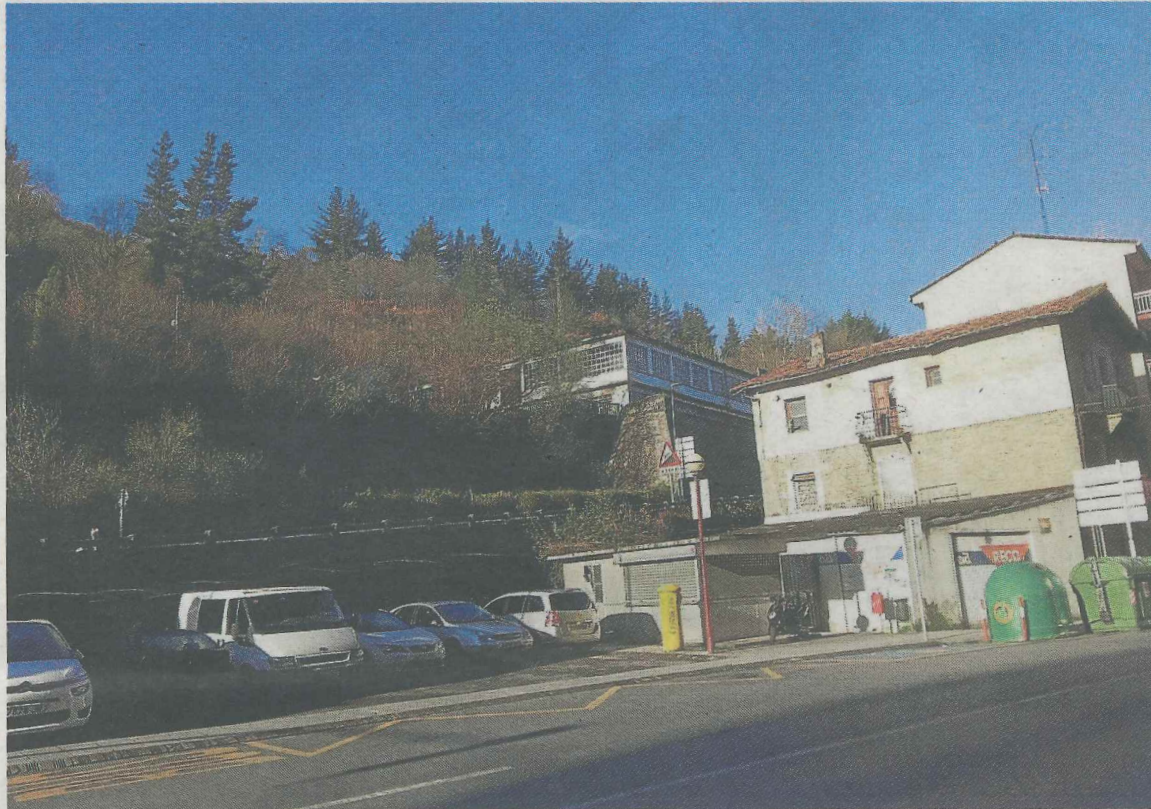
Zona por la que se tendrá acceso a las viviendas que se construirán. Al fondo, Lomy Power. AINHOA LASUEN
