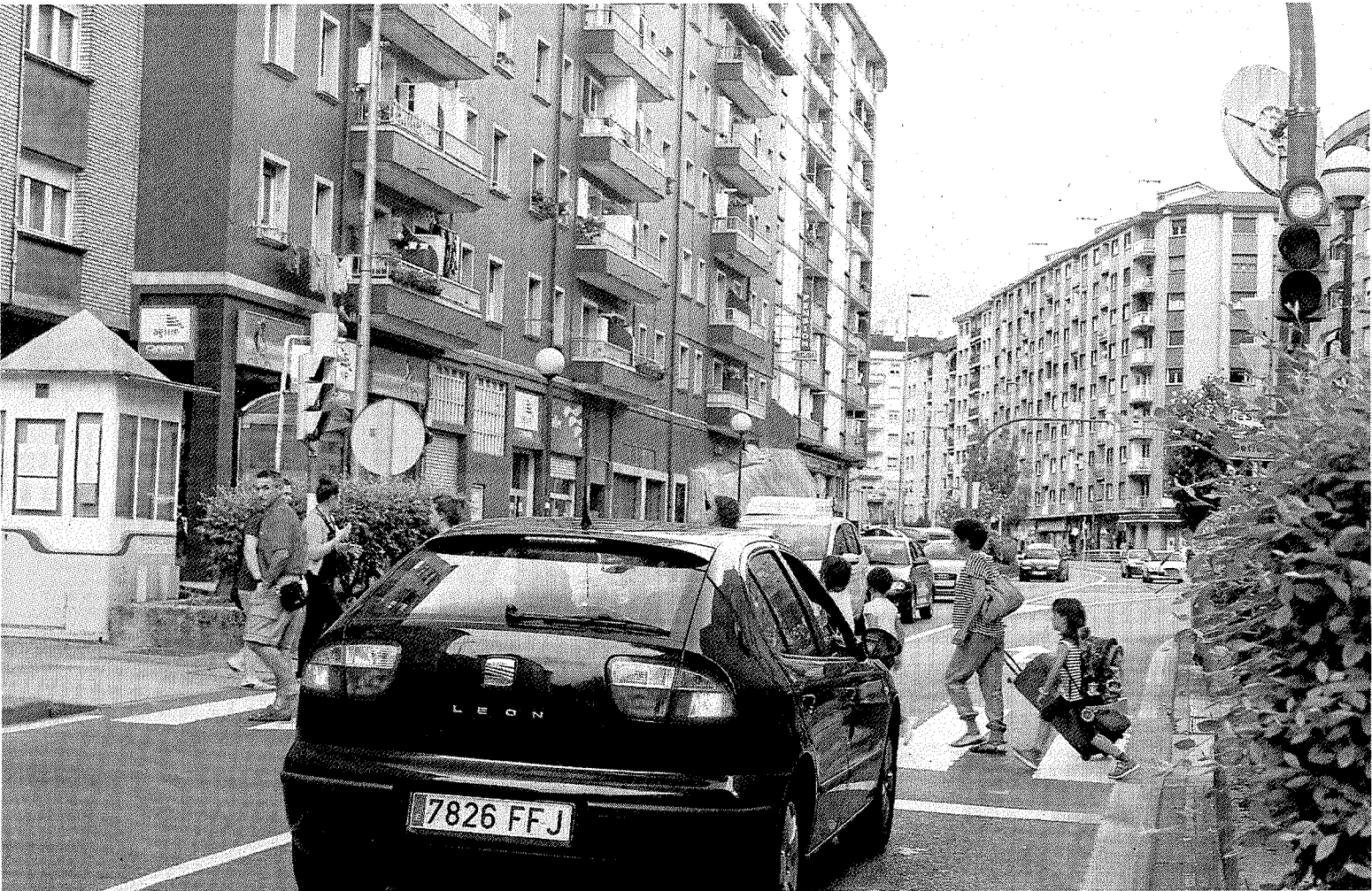
Este punto de Avenida Bizkaia soporta un gran flujo de tráfico a diario y por ello se demandaba la creación de un paso subterráneo. :: A. LASUEN
