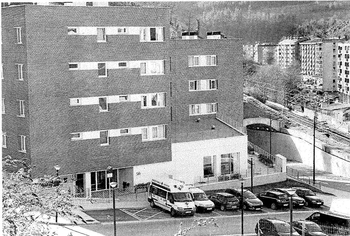
El Ayuntamiento mantiene contactos con la Residencia en relación a la instalación de fibra óptica. ■ A. L.
