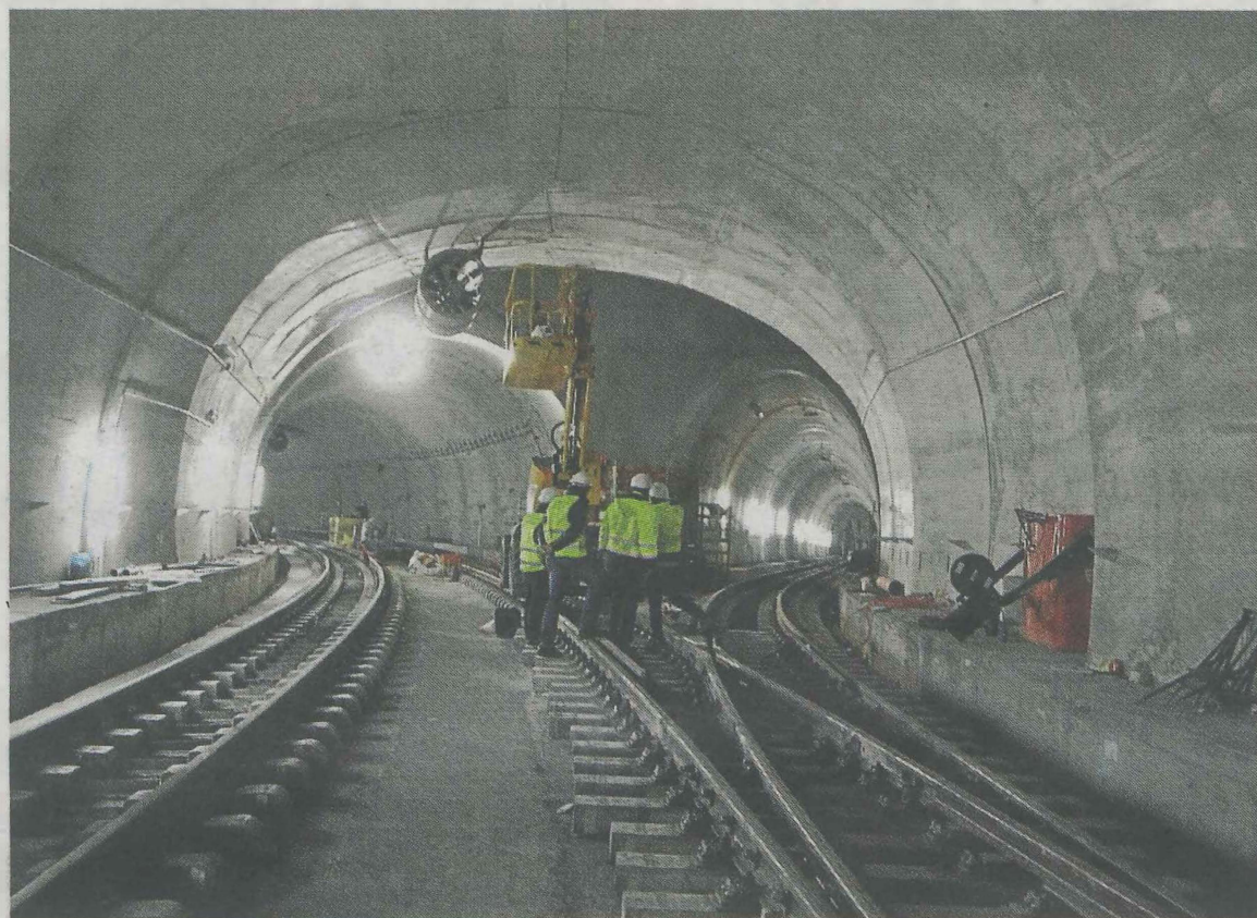
La 'vía mango' (a la derecha) permitirá el aparcamiento de vagones. :: A. LASUEN
