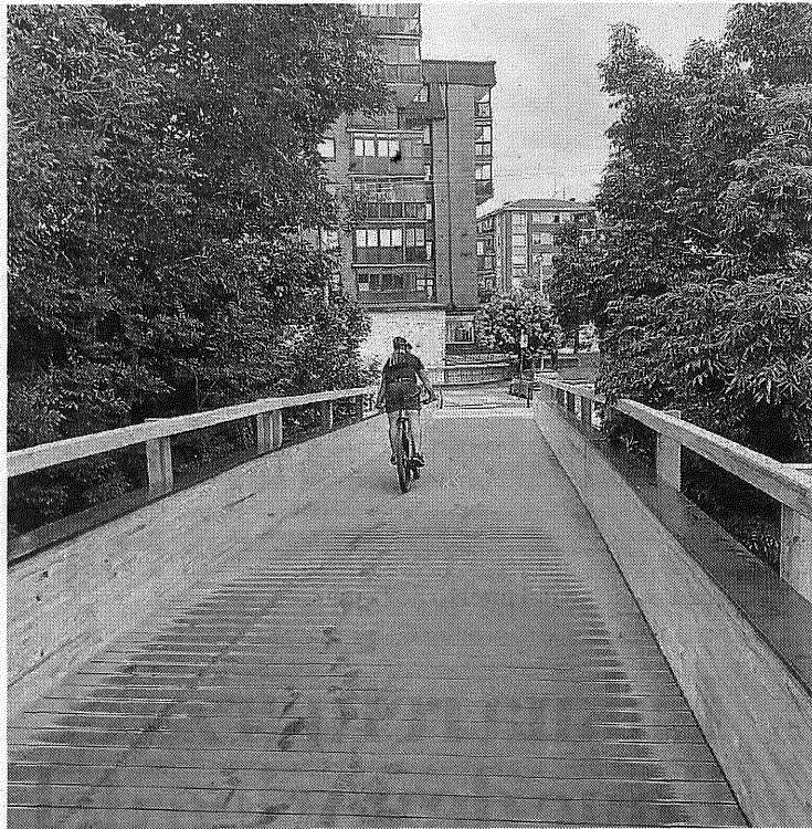
La nueva infraestructura ya está operativa. Foto: M. U.
