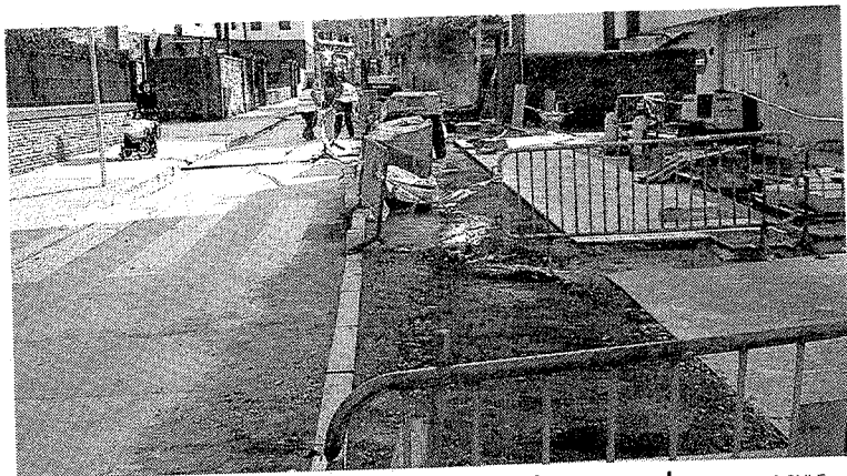
Las tareas avanzan a buen ritmo en la calle Intxaurrondo. FOTO: K. DOYLE
