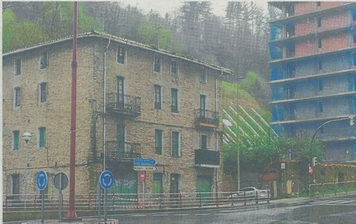
Los 1.244 metros cuadrados se ubican en el entorno del edificio residencial y el muro contiguo. A.L.
