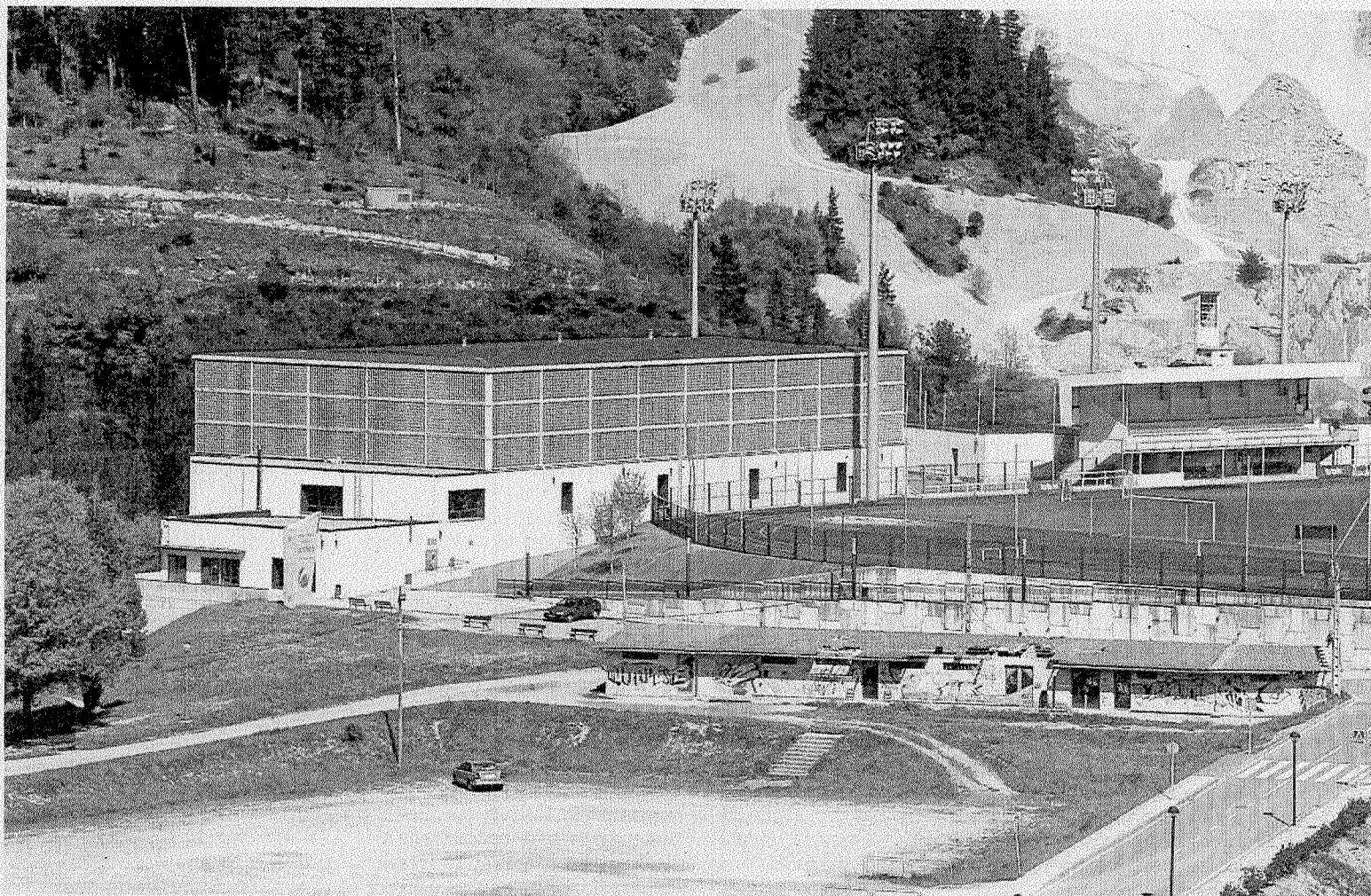
En la imagen se puede apreciar la nueva cubierta de color azul instalada en la cancha. :: AINHOA LASUEN
