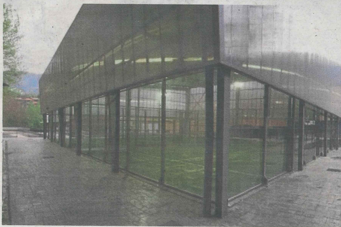
Vista exterior de la nueva infraestructura que empieza hoy a funcionar en Ermua. A. LASUEN
