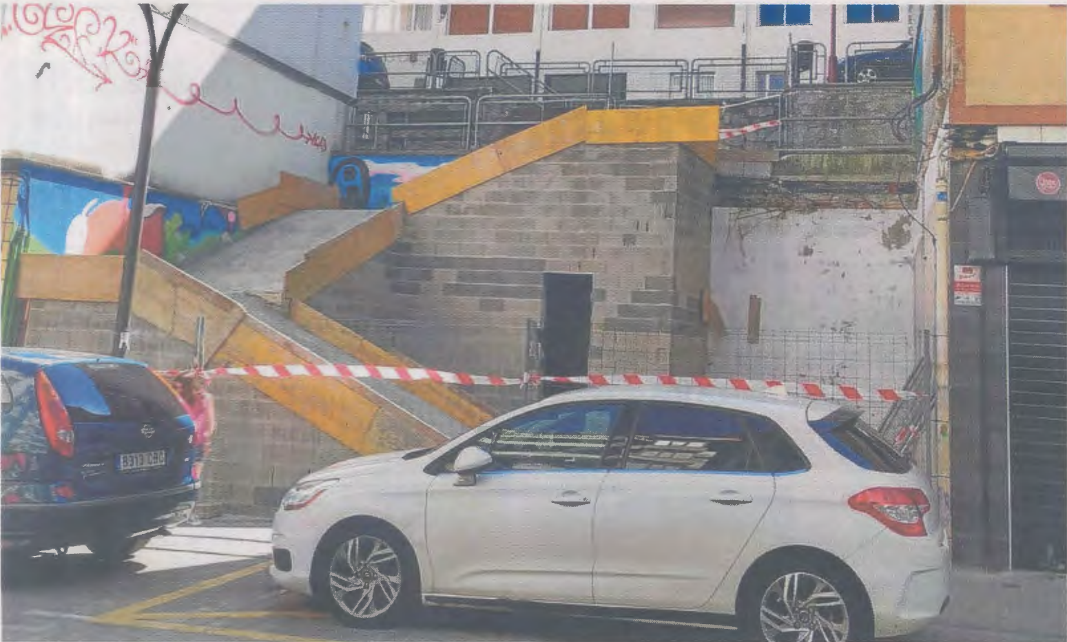
A la derecha de las escaleras en construcción, se ha dejado ya el hueco para el primer ascensor público a San Isidro. AINHOA LASUEN
