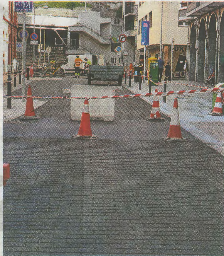
La reforma de la carretera de Unzaga está en fase de finalización. M. A.
