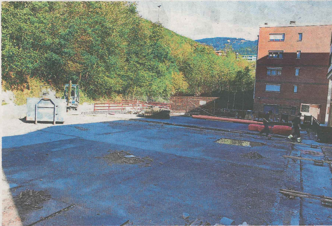
Situación actual de las obras de excavación para construir la nueva instalación. ■ A. LASUEN
