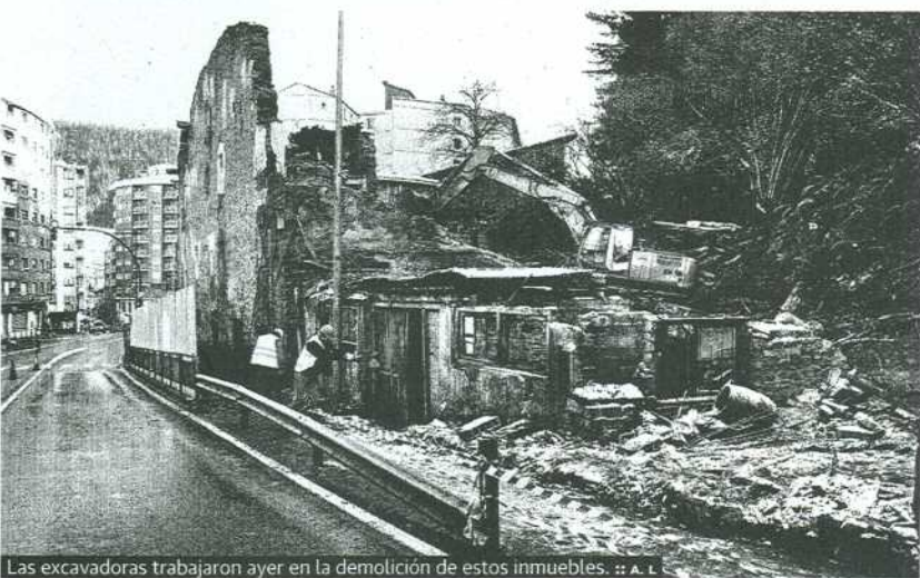
Las excavadoras trabajaron ayer en la demolición de estos inmuebles. :: A.L.
