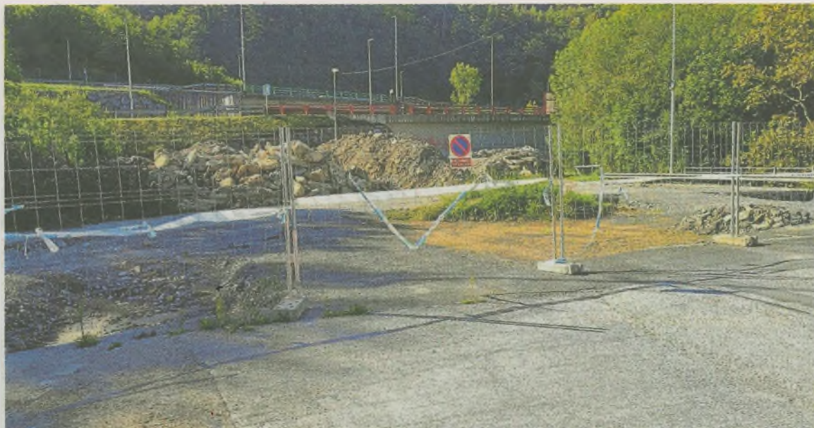
Las obras han estado paralizadas durante varios meses por el cese voluntario del anterior contratista. A. LASUEN
