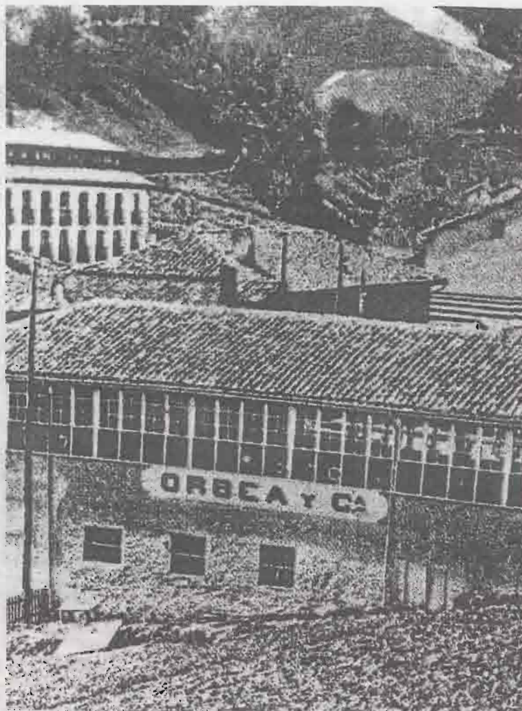
Antiguas instalaciones de la firma Orbea, en Urkizu.
