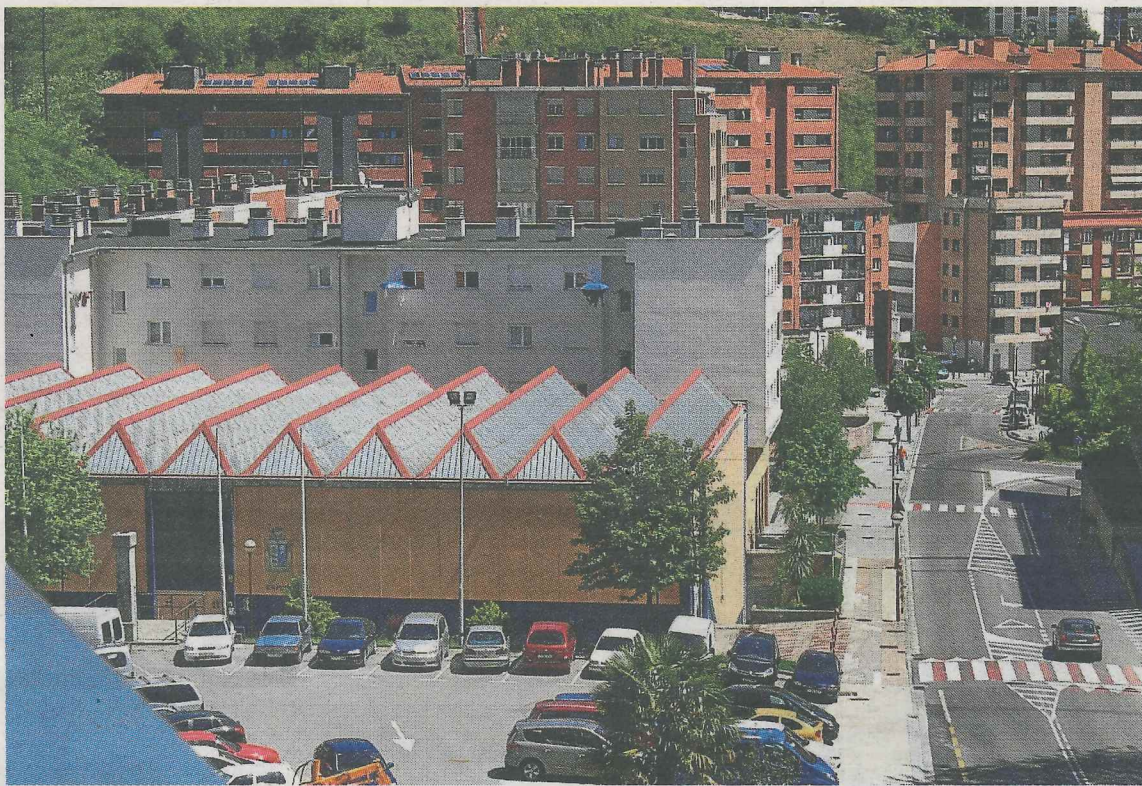
Aspecto que presenta ahora la cubierta del frontón Arizmendi. ■ A. LASUEN
