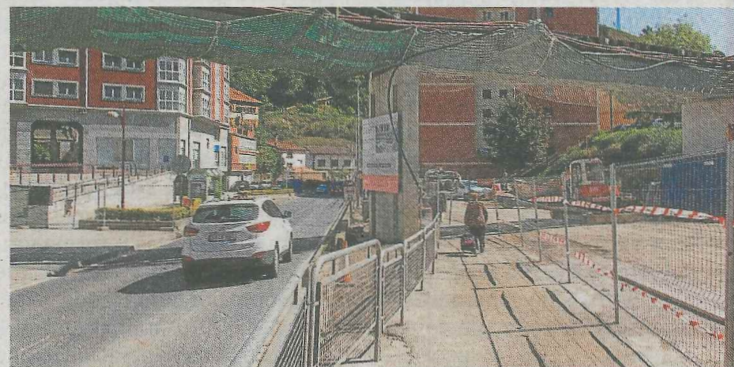
Nuevo acceso provisional. :: ITURRIAGAGOITIA
