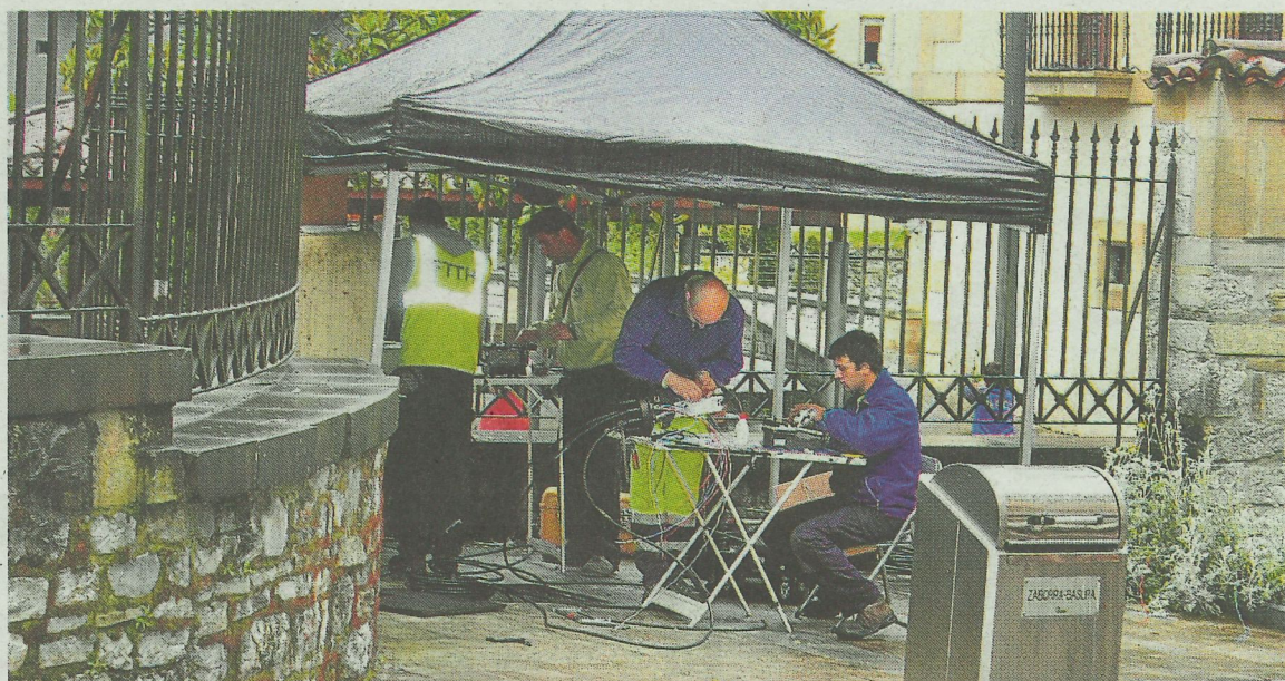
Operarios trabajan en las labores de mantenimiento de la fibra óptica municipal. A. L.
