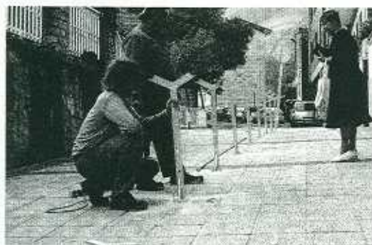
BARANDILLA. Su colocación genera cierta polémica. /IASATI
