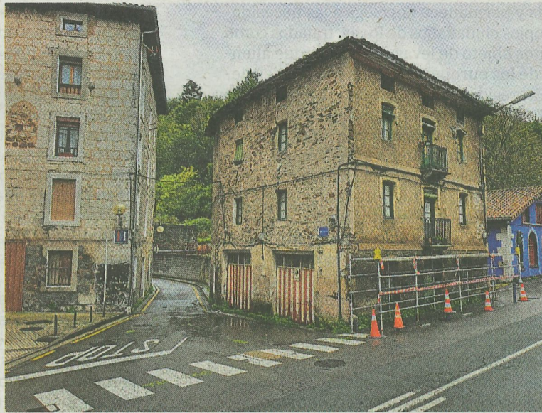
Edificio que se retirará para mejorar el acceso a Osio. SALEGI
