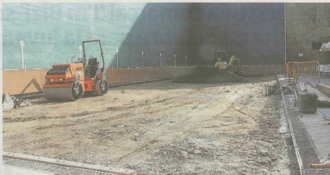
Ayer se levantaba la solera del frontón, para echar la definitiva en los próximos días. A. LASUEN
